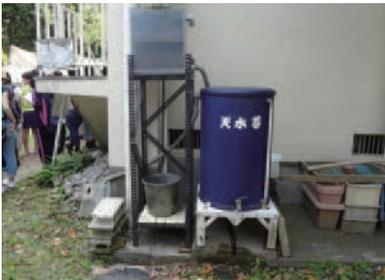
体育館の屋根から雨水を取水する“天水樽”。天水樽の下にはビール箱と砂利による雨水浸透槽が手作りされている。
