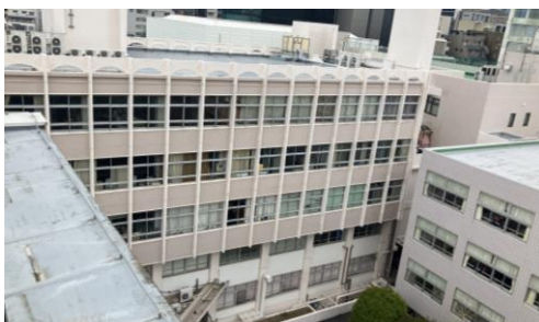
<下田陸勲記念館 解体着工前>
