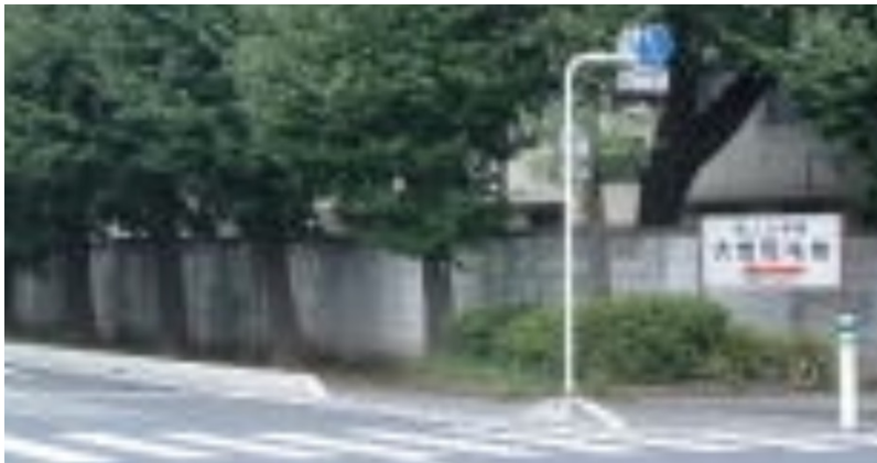
コンクリートの壁
